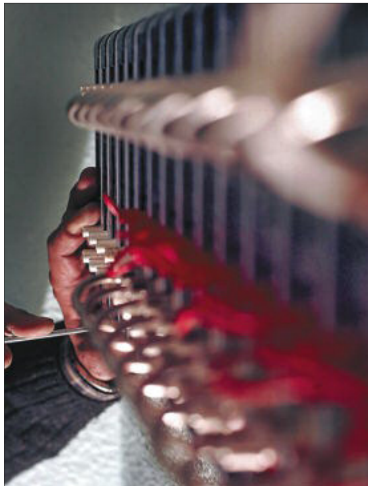
Instalación para captar la TDT en un edificio. / CARMEN SECANELLA
